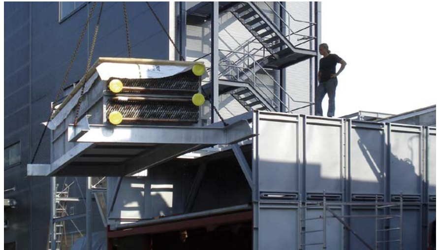
Montage eines Wärmetauschers
