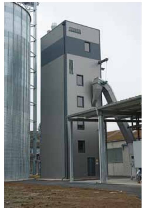
Kompakte Pelletierung in Rastenfeld im Pellet-Turm von Teccon während der Endmontage
