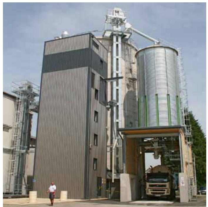
Durchdachtes Konzept beim Teccon-Pellet-Turm: Mithilfe der Schwerkraft ist aufwändige Fördertechnik überflüssig geworden
